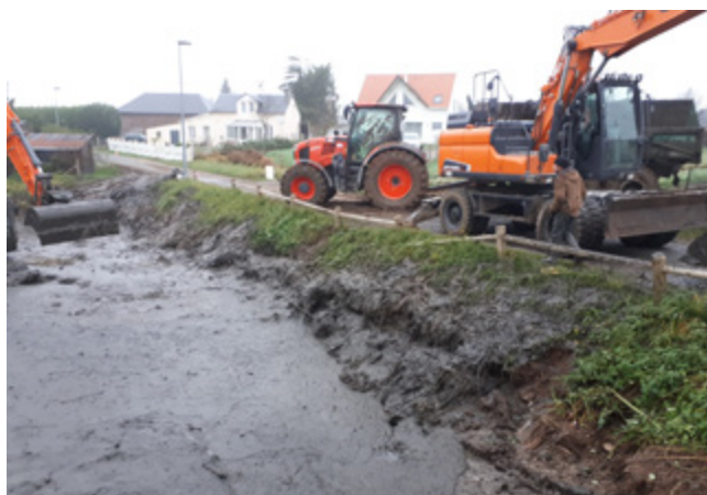
Mare des chaudières en travaux
