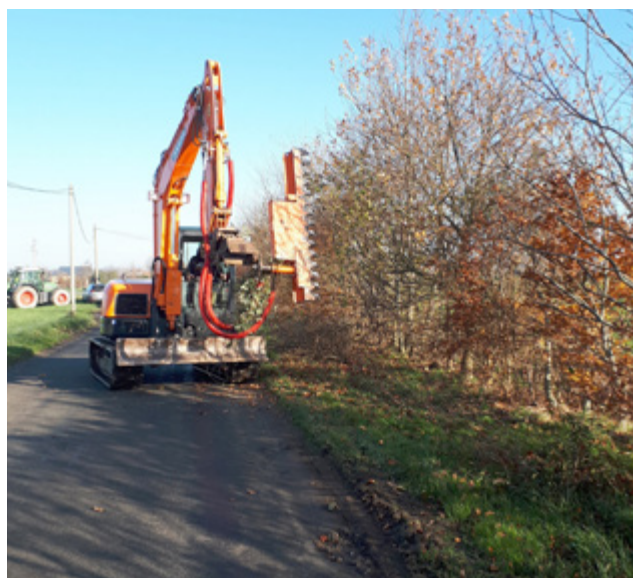
Taille haie bocagère route d'Alençon
