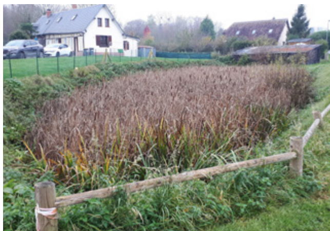
Mare des chaudières avant curage
