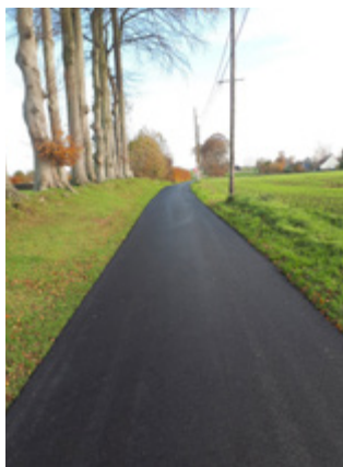
Rue de Maréfosse après
