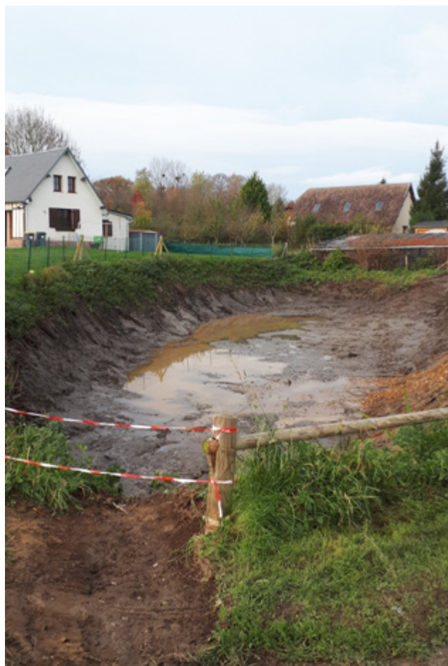
Mare des chaudières après curage
