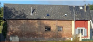
La Cerlangue. À droite l'abattoir (enduit rouge) transformé en logis dans les années 1990, à gauche la grange (en brique) transformée en atelier communal à la même époque.
