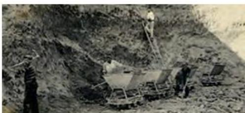
Extraction de l'argile dans une briqueterie du pays de Caux. Les briqueteries n'étaient jamais très éloignées des fours à chaux.
