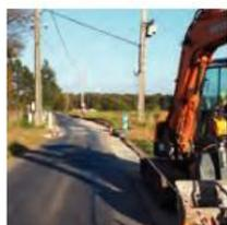
Un caniveau qui traversait une chaussée dans le lotissement « Clos St Jean » était défaillant ; il présentait des risques pour les piétons et les véhicules. Celui-ci a été supprimé et remplacé par du goudron, tout en préservant la continuité de l'évacuation d'eau lors de pluies.
