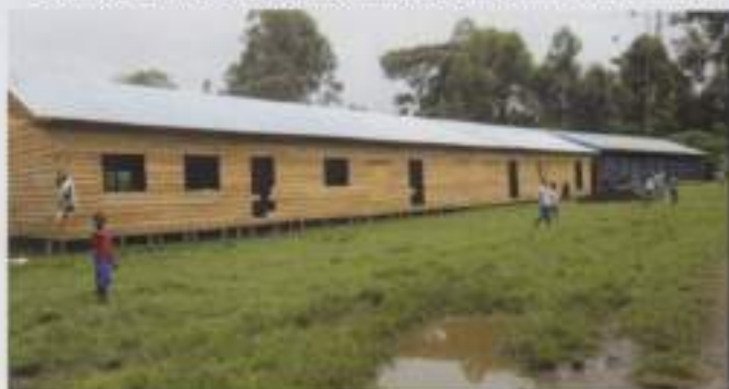
Réhabilitation école primaire en RdCongo.
